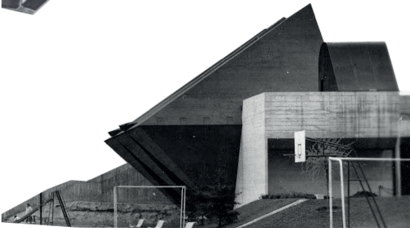
Chaufferie Rue des Pichets
