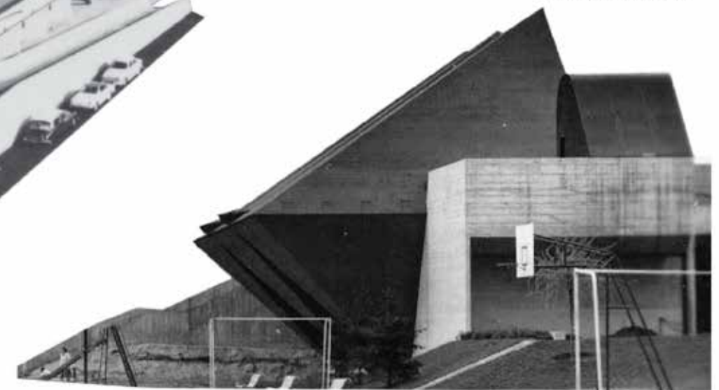
Chaufferie Rue des Pichets
