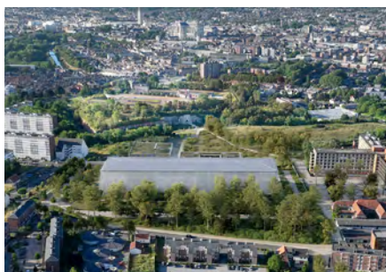
Amiens – Nouveau pôle de conservation de la Bibliothèque nationale de France: Construction d'un bâtiment d'archives avec ses salles robotisées et sous oxygène rarifié, ainsi qu'un bâtiment de bureaux-paysages. Livraison prévue en 2029. Crédit: TVK / Carmody Groarke, BnF Amiens, vue Nord © Studio Arho.
