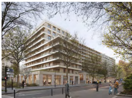
Paris – Restructuration d'un immeuble de logements Porte de Vanves: Démarrage du chantier pour la transformation d'un ensemble immobilier de 241 logements, pour la RIVP , avec JBMN architectes Crédit: MGAU Paris Porte de Vanves © Vincent Atelier.
