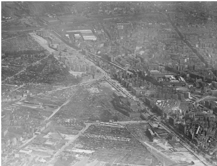
Vue aérienne de la démolition des bastions de l'enceinte de Thiers et de la construction des habitations à bon marché ( HBM ), 8 avril 1926. Photographie argentique. Mission CFOD-1285 , IGN . Crédit : Photothèque nationale / IGN .
